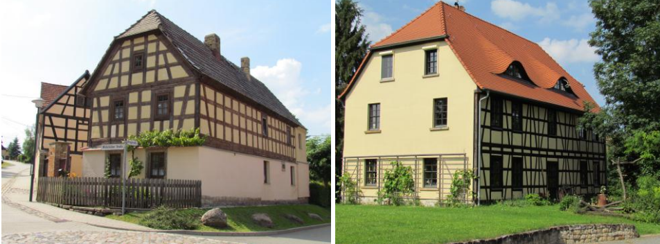
Abb. 37: Sanierete Wohngebäude in den Ortskernen von Keutschendorf und Wühlitz (Fotos: Wenzel & Drehmann, 02.07.2013)
